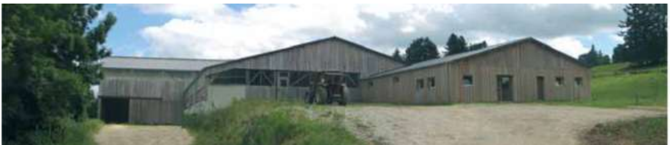
Mise à profit du dénivelé dans la construction
